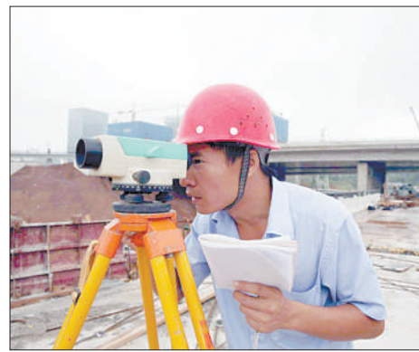
技术人员精心测量桥面标高。张骥摄 政立交桥,该桥为全互通立交。图为 南宁平象立交桥是南宁市规模最大的市 由中铁十八局集团二公司承建的
