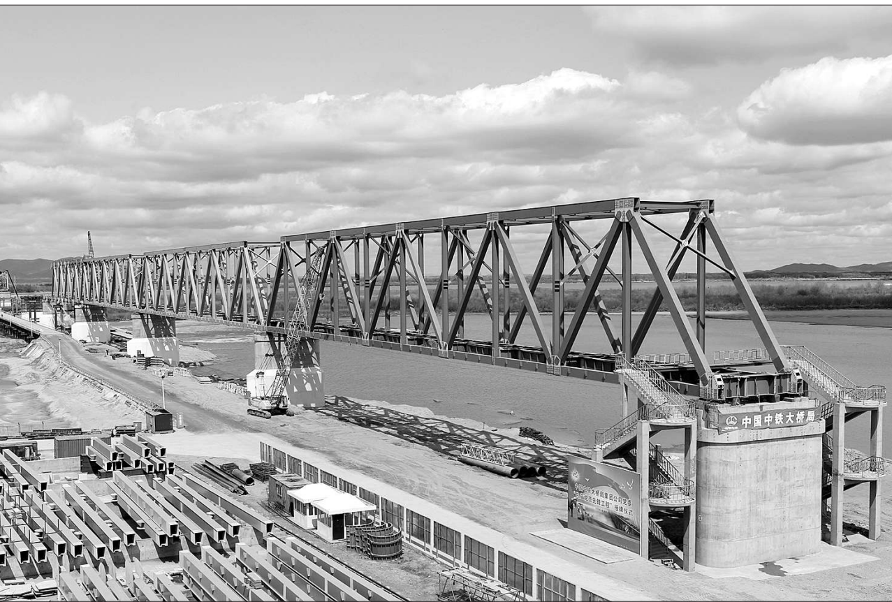
正在施工的中俄首座跨界河铁路桥——同江中俄铁路大桥4月25日顺利度过凌汛期,大块的冰排已安全漂过施工栈桥区。目前,大桥主桥桩基础已全部完成,钢梁架设已完成7孔,大桥雄姿初现。同江中俄铁路大桥是黑龙江省与俄罗斯2981公里边境线上的第一座界河桥。新华社发(成莉玲摄)
