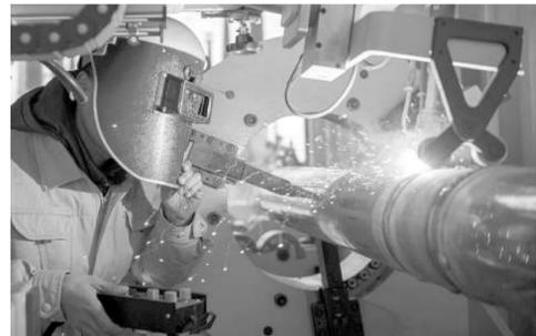
12月24日,电力工人在操控变电站管母焊接机器人进行焊接作业。
