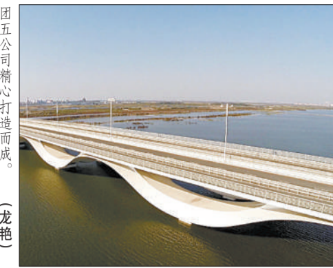
团五公司精心打造而成。(龙艳) 中新生态城落成,该桥由中铁十八局集团“型钢拱桥”支撑的连续梁桥在天津
