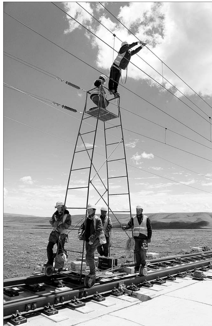
在位于甘肃省张掖市的青藏高原祁连山脉,中铁电气化局集团西安电化公司的接触网工在调试电气化网线。
