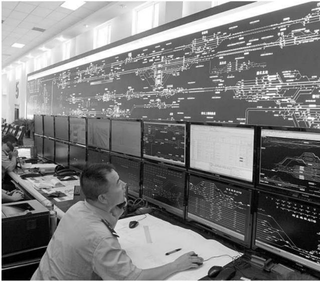
大秦重载枢纽站集控楼,是太原铁路局在大秦线上建设的集车、机、工、电、辆、供电和通信7个系统部门为一体的行车调度指挥集中作业场所,配备全路最先进的CTC——列车运行集中控制系统,TDSC——调度指挥系统,G网——列车通讯系统,以及5T——车辆故障检查系统,为确保大秦线重载列车安全运行提供了可靠的基础保障和技术支撑。
