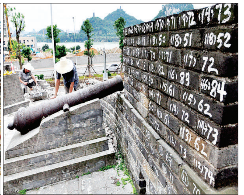
柳州东门城楼始建于明洪武十二年(公元1379年),距今已有600多年历史,为广西重要的古城遗址。为恢复东门城楼历史风貌并保证古建筑的安全,柳州市从6月起对城楼一段34米长、11米宽、9米高的古城墙进行拆除重建。为了做到“修旧如旧”,一块砖都不能错,拆除前需对城墙上的近8万块砖逐一进行编号,方便重修时将每一块砖恢复到原位。左图6月19日拍摄的柳州东门城楼。右图工人在拆除城墙上已写上编号的青砖。 新华社发(李书厚摄)
