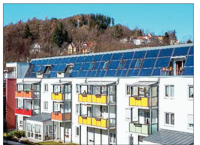
德国城市伊默瑞的一个屋顶光伏发电系统。
