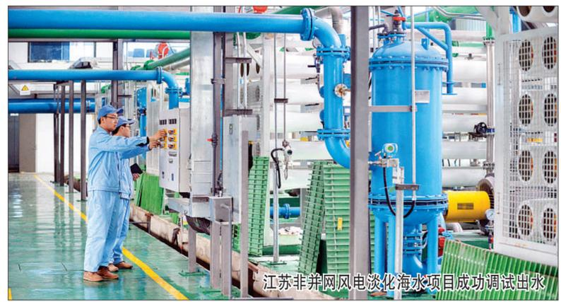
5月19日,江苏盐城大丰市1万吨非并网风电淡化海水项目首台生产线成功调试出水。该项目不仅将风能应用于海水淡化,而且实现了“非并网”,即由1台2.5兆瓦的永磁直驱风电机组直接为海水淡化装置供电,形成在百平方公里范围内独立供电的微电网系统。图为工作人员在海水淡化车间检查维护海水淡化设备。 新华社记者 沈鹏摄
