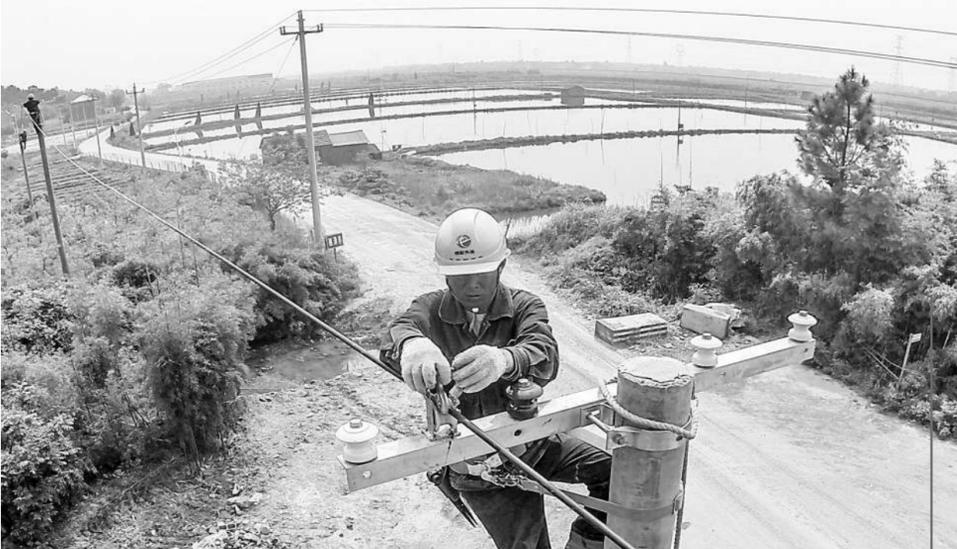
杭州市余杭区从2014年初开始进行“美丽乡村”电力改造规划,规划通过变压器扩容、老旧线路改造,安装智能漏电保护器等工作,改善农村电网,提升农村百姓生活品质。图为电力施工人员在杭州市余杭区港南村架设新的供电线路,替换老旧线路。 新华社 徐显摄
