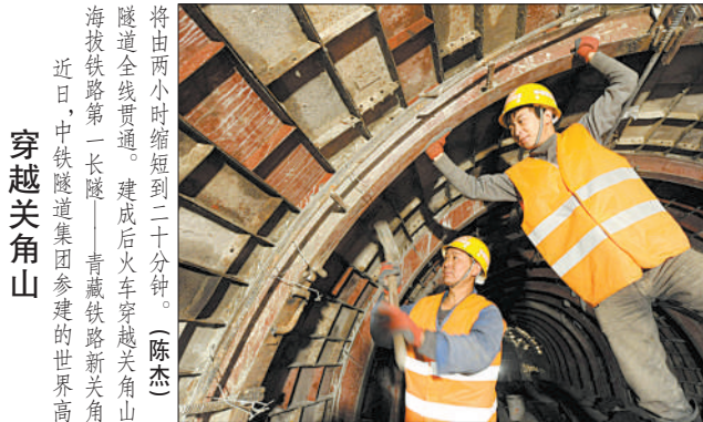
将由两个小时缩短到二十分钟。(陈杰) 隧道全线贯通。建成后火车穿越关角山海拔铁路第一长隧——青莱铁路新关角
