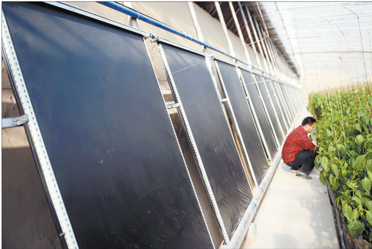
甘肃白银市白银区现代农业科技园采用太阳能技术,示范推广日光温室循环利用及技术集成项目。这项技术在蔬菜大棚里安装太阳能水幕,白天利用太阳能对水幕中的水进行加热,晚间释放热量加温大棚,有效解决大棚夜间和冬季加温难题,达到节能减排的效果。 新华社记者 聂建江摄
