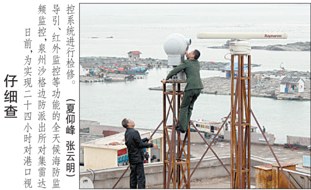
控系统检修。(夏仰峰 张云明) 导引、红外监控等功能的全天候海防监 频监控,泉州沙格边防派出所对集雷达 日前,为实现二十四小时对港口视 仔细查
