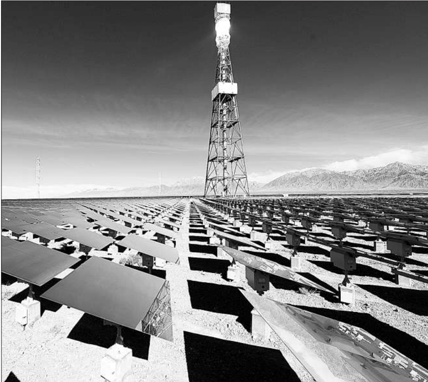
依托得天独厚的大太阳能资源和大面积的荒漠化土地，青海省加快推进柴达木盆地光伏发电产业的发展，三年间累计完成超过280亿元投资，建成超过70座光伏发电项目，形成光伏装机容量超过1600兆瓦。图为德令哈50兆瓦塔式太阳能光热发电站一期10兆瓦发电站一角。新华社记者 张宏祥摄
