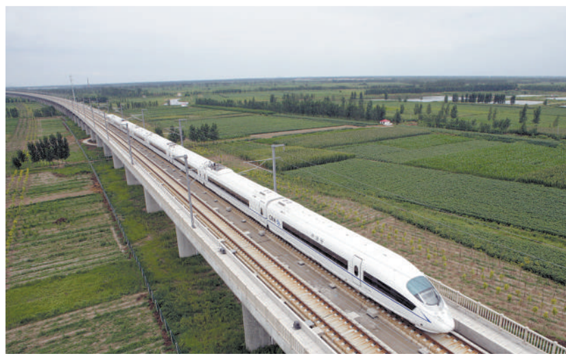
园区企业中铁电气化局集团参与建设的京津城际铁路牵引供电工程
