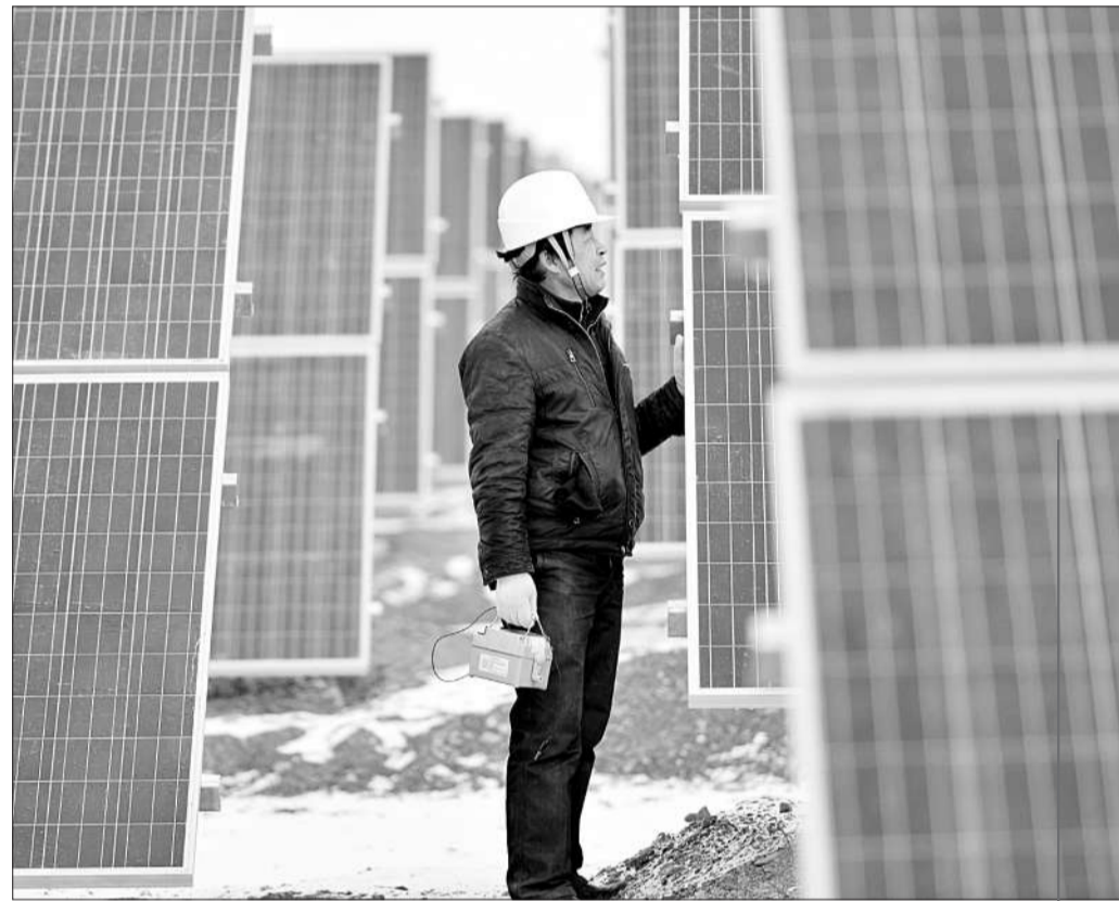
作为我国新能源发电的重要省份之一,甘肃省目前已建成敦煌、金昌、嘉峪关等7个百万千瓦级光伏电站,光伏发电装机容量突破300万千瓦。针对光伏产业快速发展态势和电力输送难题,甘肃省2014年将更加注重就地消纳,通过积极建设配套智能电网工程和引导耗能产业向新能源富集地区转移等方式缓解目前面临的输送能力、调频调峰、电力电量消纳等问题,以促进光伏产业健康持续发展。图为2月17日,一名技术人员在甘肃阿克塞光伏发电基地内检查设备。
