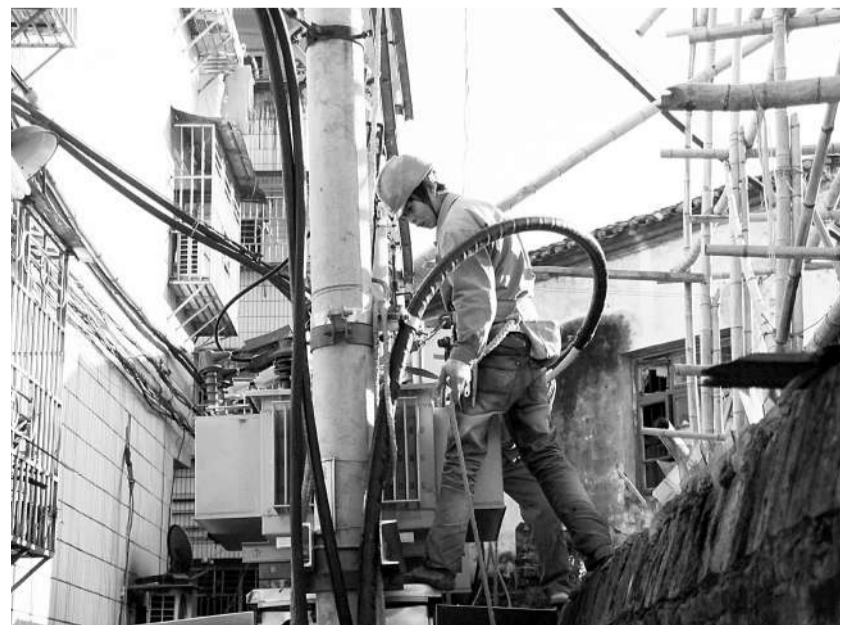
近日,国家电网青田县供电公司组织员工对青田县老旧小区过负荷运行线路及设备进行重点排查,同时结合年度电网改造计划,优先安排重载、满载配电网线路和设备的更换改造。图为青田县供电公司员工在天津小区检查变压器。新华社发
