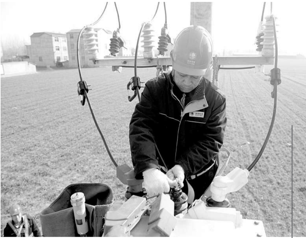
春节临近,安徽省阜阳市200多万名外出务工人员陆续返乡过年。空调、电炉等大功率家用电器的集中使用,给当地农村电网造成负荷压力。为提高农村电网的供电能力,阜阳供电公司提前启动农网改造升级,满足春节期间农村用电需求。图为1月22日,在阜阳市市老庄镇官营村,电力工人正在进行变压器增容改造。
