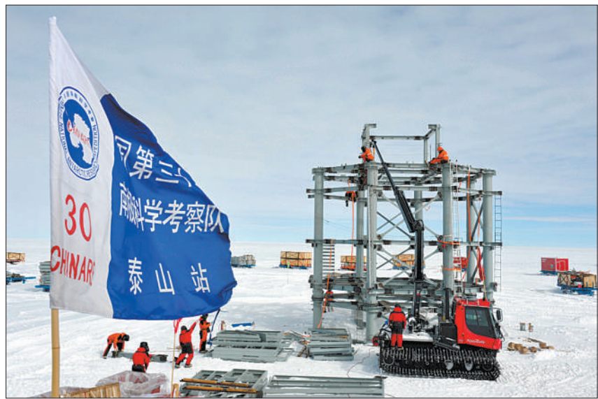
北京时间1月3日下午2点半左右,中国新建的南极泰山站完成最后一根顶梁吊装作业,泰山站钢结构主体顺利封顶。 新华社发(唐志坚摄)
