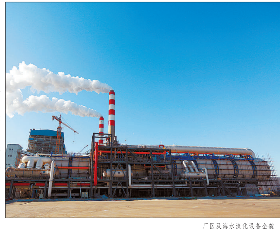
厂区及海水淡化设备全貌
