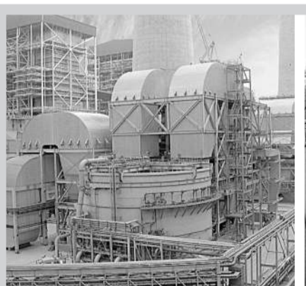
广东粤电台山发电厂2X600MW机组脱硝工程
