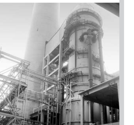
重庆铝业环保搬迁大板钉项目动力车间2x330MW机组烟气脱硫项目(旗能脱硫项目)
