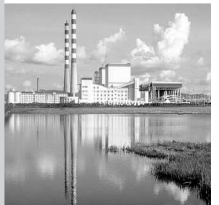
内蒙古上都电厂2X600MW脱硫工程
