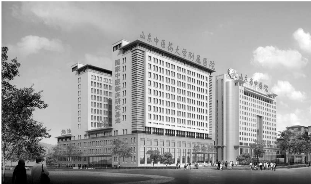
山东省中医院东院区基地综合楼
