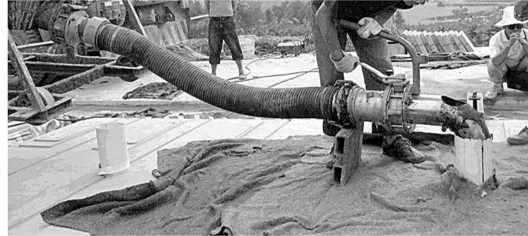
水泥砂浆灌注现场
