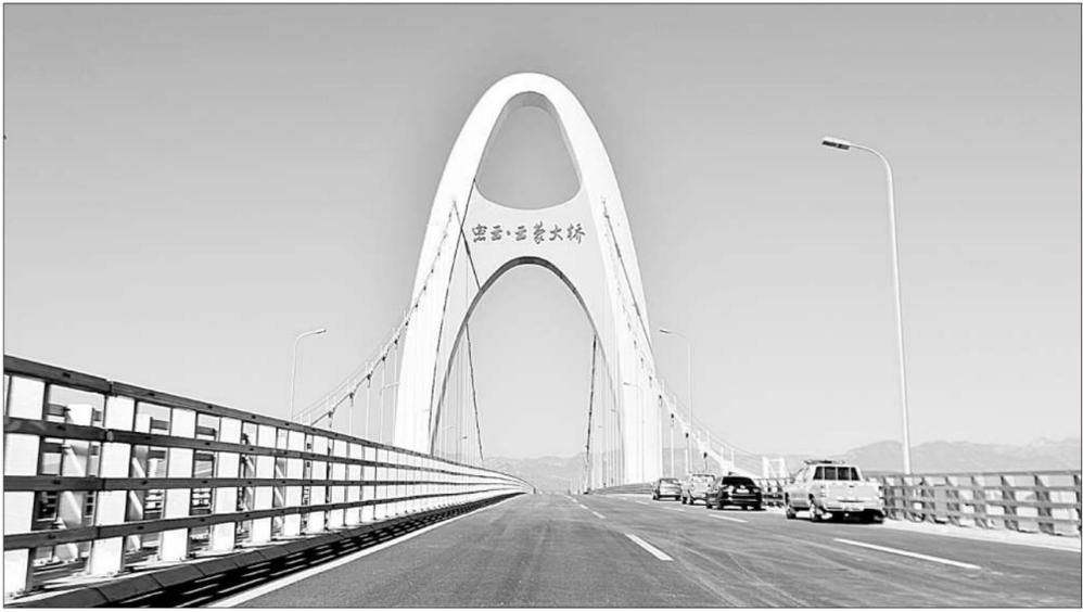
11月14日,连接京承高速公路和密云经济开发区的密云云蒙大桥正式通车。这座大桥飞跨潮白河,全长744米,桥梁主塔外形采用“种子”造型,属单塔自锚式异型悬索桥。图为北京密云云蒙大桥。
