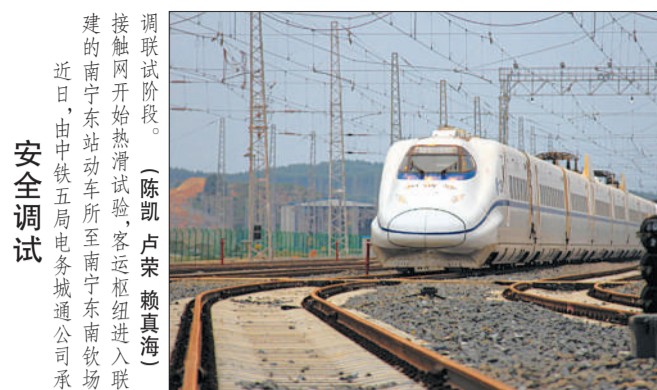
安全调试 调试阶段。陈凯 卢荣 赖真海
