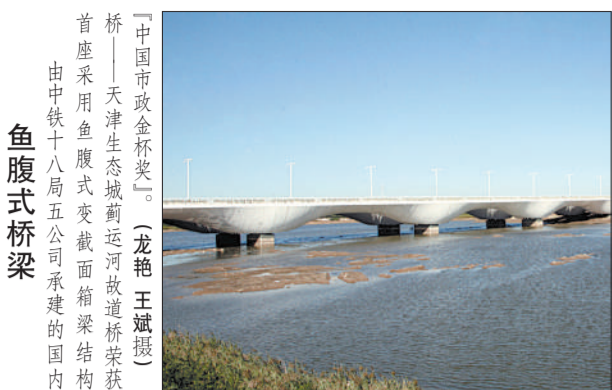
鱼腹式桥梁 “中国市政金奖”。(龙艳 王斌摄) 桥”天津生态城到运河河道桥梁获
