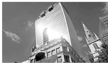
近日,英国伦敦圣保罗大教堂附近的一座大楼成为新闻焦点,因为它的玻璃幕墙能反射出强光,甚至将一辆停在对面的捷豹汽车后视镜和车身烤化了。
