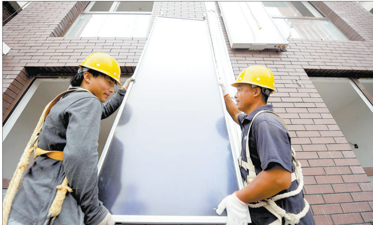
8月底前，北京海淀区辛店安置房项目将全部使用上壁挂平板太阳能热水器... 这也是北京在保障房项目中首次大面积安装应用太阳能集热系统。
