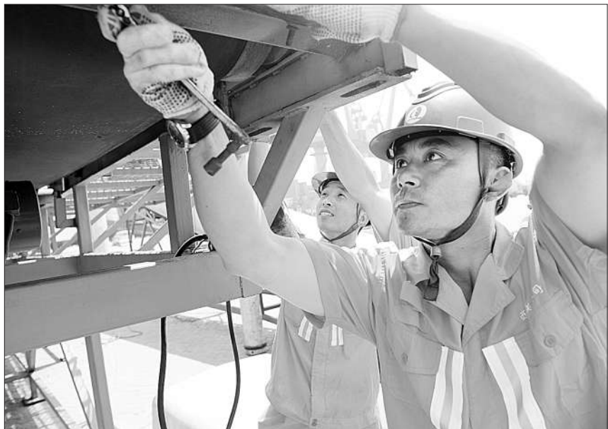
图为青岛港大港工器具队副队长杨军在维修传送带。
