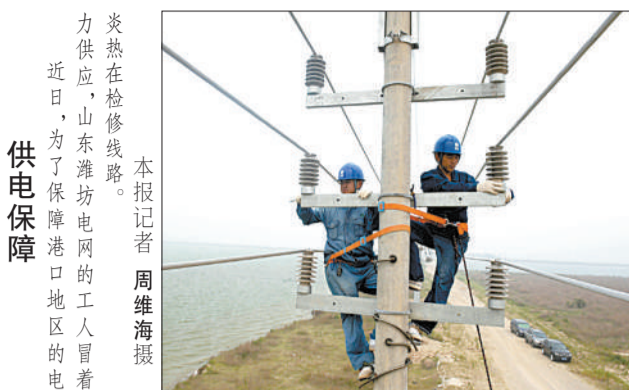
近日，为了保障港口地区的电力供应，山东潍坊电网的工人冒着烈日，在检修线路。
