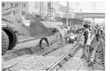
沈阳铁路局四平工务段在道岔大修施工中,充分发挥大型养路机械的优势,不但保证了道岔大修施工质量,而且提高了施工效率。图为该段在四平站道岔大修施工中利用大型机械回填石砟。孙忠仁摄
