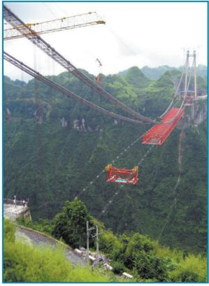
大跨度悬索桥加劲梁“轨索滑移法”架设新技术
