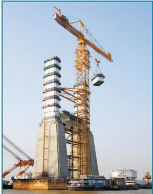
52000千牛米上回转自升式超大型塔式起重机开发与应用
