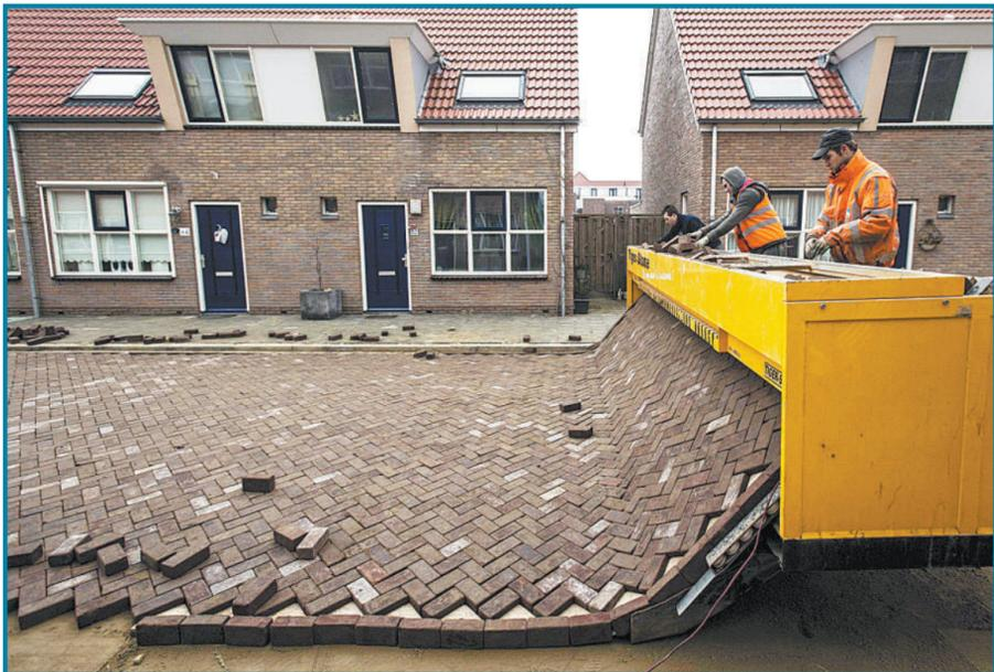
▲荷兰发明家发明的全自动铺路机。这种机器并非全自动，而是需要人工排列砖块。铺路机可以根据路面的宽度来调整铺设的宽度，可铺宽度从2米到15米。
