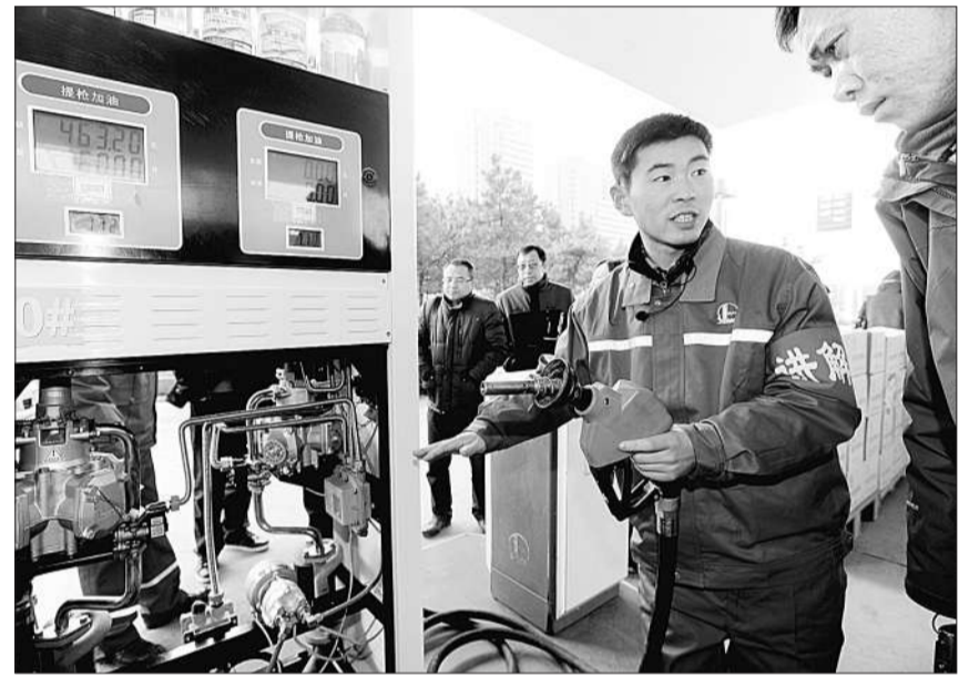
3月19日,辽宁省暨沈阳市油气污染治理工作现场会在沈阳举行,沈阳市储油库、加油站、油罐车油气回收综合治理工作正式启动。沈阳市339座加油站、8座油库、112辆油罐车将全部进行油气回收改造。图为工作人员在讲解加油站油气回收系统。 新华社发(张文魁摄)
