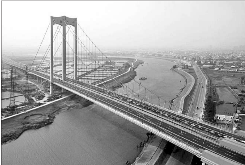
佛山一环工程建成迄今仍是世界最大跨度的独塔多索面混合梁自锚式悬索桥——平胜大桥。在此之前,世界上同类大桥跨度最大只有100多米,平胜大桥一举将这一纪录提高到350米。目前,平胜大桥的创新技术已成功应用到长沙三汊矶湘江大桥、广州猎德大桥等多座大桥建设中。
