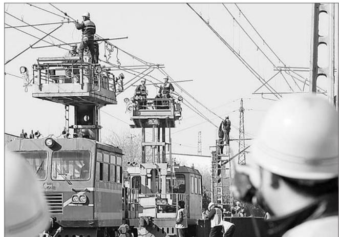
1月25日,郑州铁路局供电段的工人在对接触网进行整修。据介绍,2013年春运郑州铁路局预计发送旅客954万人次,同比增长6.9%。为了确保春运安全有序,该局已对投入春运的142列2379辆车底、1155台机车进行了整备,对线路、接触网、信号机及车站各类服务设施进行检查整修,对从路局机关和各单位抽调的2600多名临时乘务人员进行培训。
