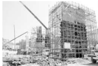
立交桥主墩施工场景
