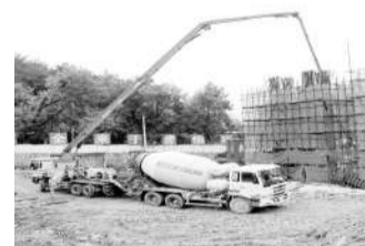
墩身混凝土施工
