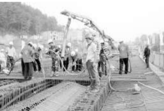
主线桥现浇梁施工
