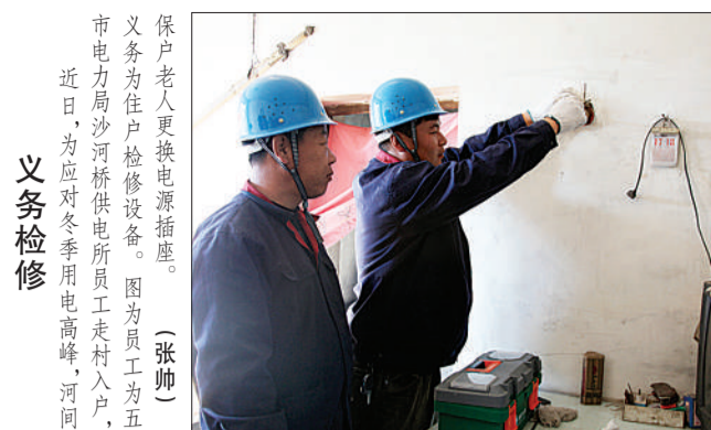
保护老人更换电源插座。(张帅) 义务为住户检修设备。图为员工为五 市电力局沙河桥供电所员工走村入户， 近日，为应对冬季用电高峰，河南
