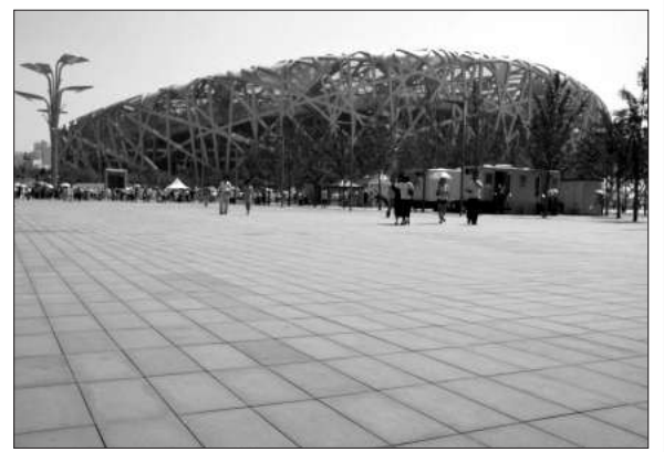
图3 “仁创生泰硅砂透水砖”成功应用于奥运鸟巢景观大道。
