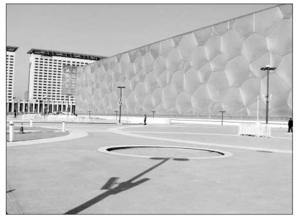
图1 仁创透水砖在奥运水立方工程成功应用。
