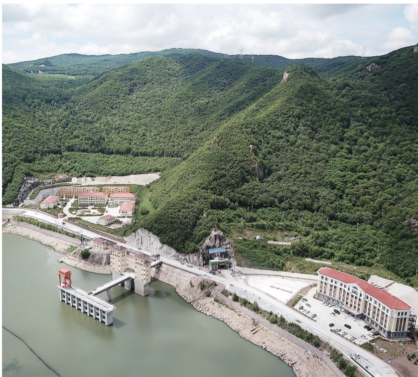
近年来,东北三省围绕资源优势加速布局清洁能源。由一座座陆地、海上风场,光伏和生物质电站提供的绿色电能,正在东北能源供给中扮演重要角色。图为国网新源黑龙江荒沟抽水蓄能电站下水库一角。 新华社记者 王建成 摄
