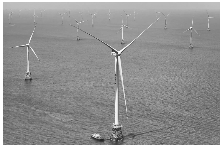
图为16兆瓦海上风机。（三峡集团供图）
