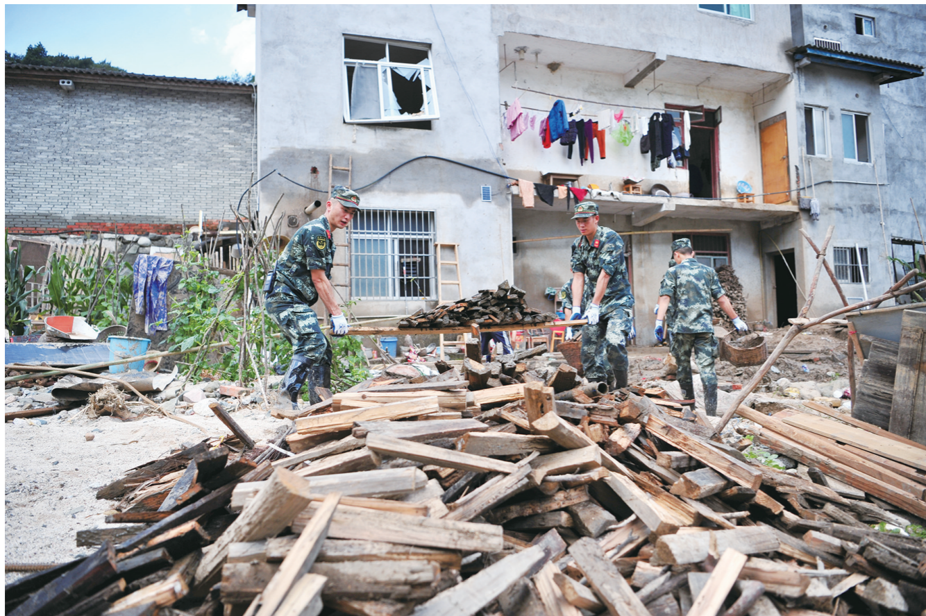
湖北省宜昌市,抢险突击队全力抗灾救灾,严防次生灾害发生,尽快恢复受灾群众生产生活,努力把灾害损失降到最低,最大限度维护广大人民群众生命财产安全。
