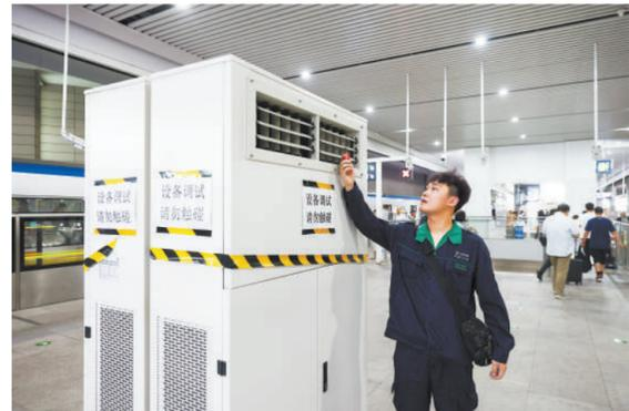
在北京地铁13号线清河站，工作人员测试冷风机的制冷效果。
