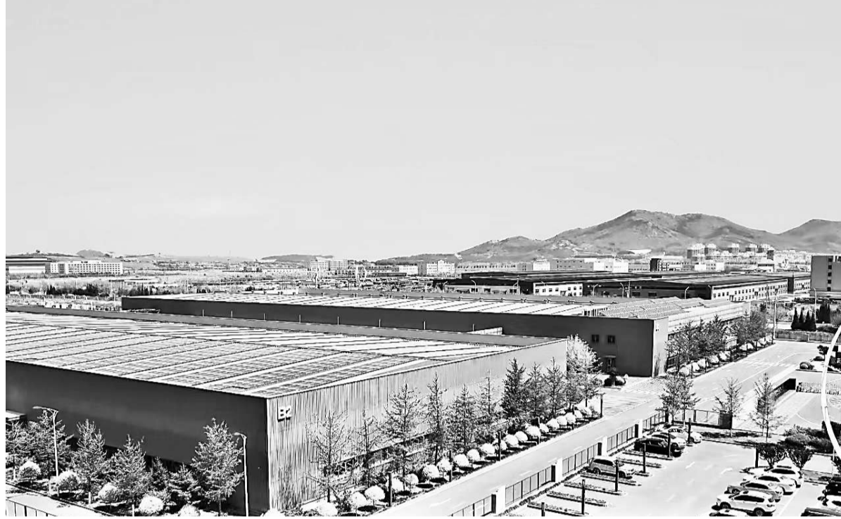
图为位于大连高新区的融科储能数字化产业基地。
