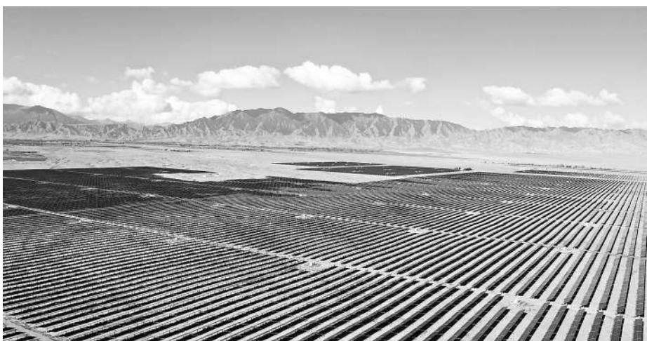
图为甘肃省某光伏发电项目。建设“沙戈荒”地区大型新能源基地，能推动沙漠治理。新华社记者 金良快摄
