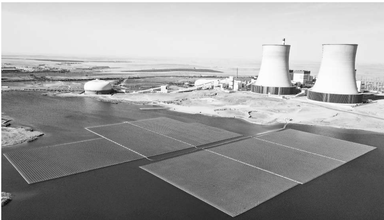
图为漂浮分布式光伏发电项目。 新华社记者 王鹏摄
