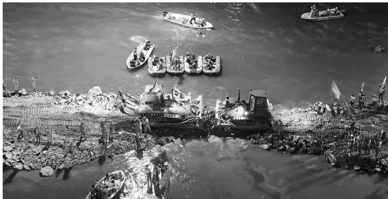
7月8日22时31分,记者在湖南华容县团洲垸洞庭湖大堤决口封堵现场看到,团洲垸洞庭湖大堤决口完成封堵。图为7月8日晚拍摄的团洲垸洞庭湖大堤决口封堵现场(无人机照片)。新华社记者 陈思汗摄
