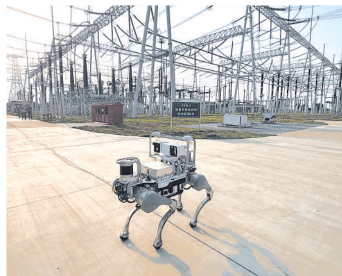
图为国网湖北电力打造的“空地立体巡检”新型智能巡检场景。孔轶摄
