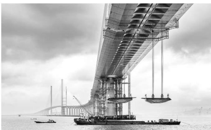
黄茅海大桥最后一榀钢箱梁吊装现场。 受访单位供图
