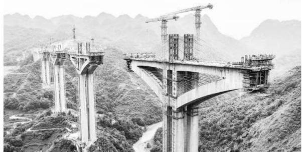
6月17日,随着六枝特大桥8.9号主墩空腹区交汇,由贵州交建集团所属路桥集团承建的纳晴高速六枝特大桥全桥上下弦全部完成“交会对接”,即将转入“刚构桥”施工阶段,大桥建设取得了阶段性胜利。
