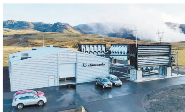
位于冰岛的直接空气捕获工厂 Climeworks,用风扇吸入周围空气以提取二氧化碳。 图片来源:美国有线电视新闻网
